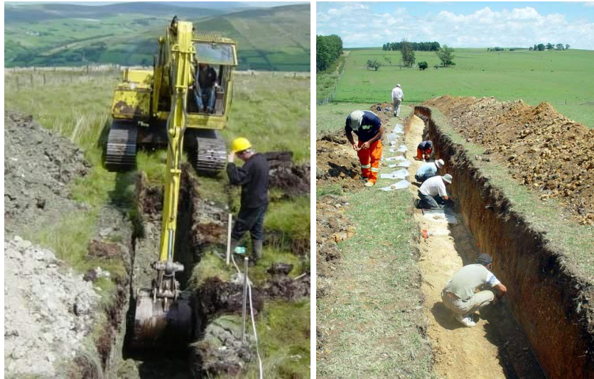
Calicatas. A la izquierda, excavación de una calicata; a la derecha, muestreo discontinuo ( chip-sampling ) de una calicata (imágenes 1,2 ).
