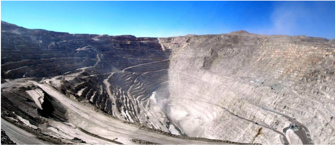
La operación minera de Chuquicamata (vista hacia el norte). Dimensiones (aproximadas): 4,3 km de largo, 3 km de ancho y 800 m de profundidad. Mayo de 2006.
